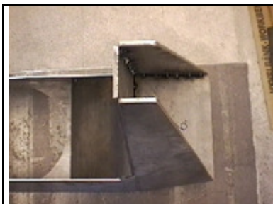
passgenau geschnittene Blechteile mit 5mm Wandstärke werden von innen heraus zusammengeheftet
