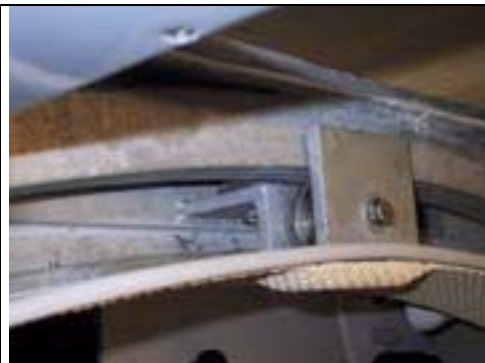
Eines der 4 Auflager im Detail
