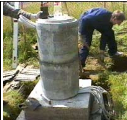
Die Instrumentensäule mit ihrem stufenförmigen Fundament
