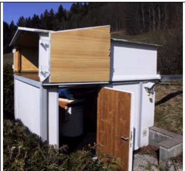
Die niedrige Eingangstür erfordert eine gebückte Haltung beim Eintritt in das Gebäude
