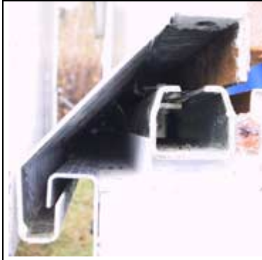
Laufschiennenprofil und Querschnitt der „Windfalle“ gegen eindringenden Flugschnee
