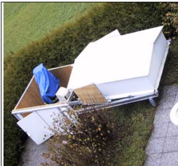
Neben dem abgeschobenen Dach hängt eine der beiden Laufschienenabdeckungen
