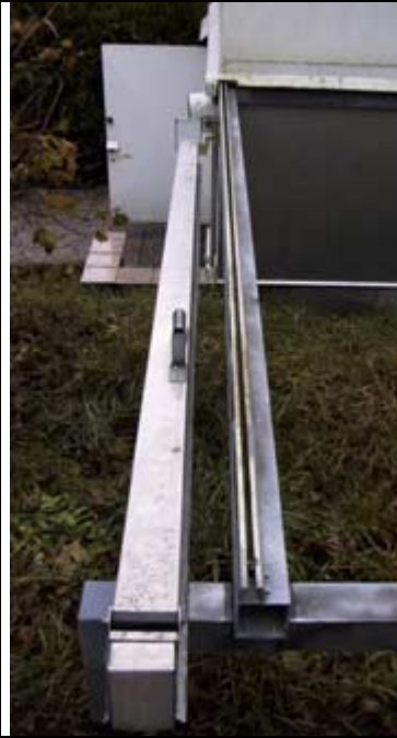
Laufschiennenprofil und Querschnitt der „Windfalle“ gegen eindringenden Flugschnee
