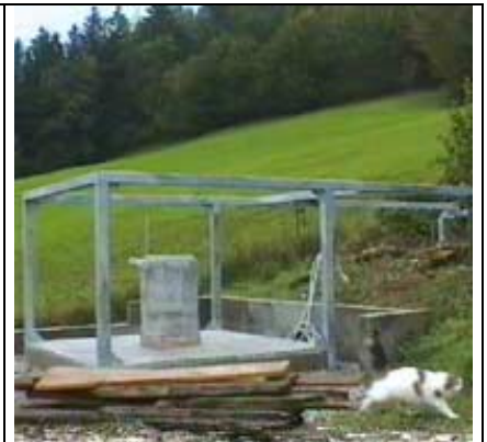
Stützmauer und Fußbodenestrich. Die Laufschienträger sind angeschraubt
